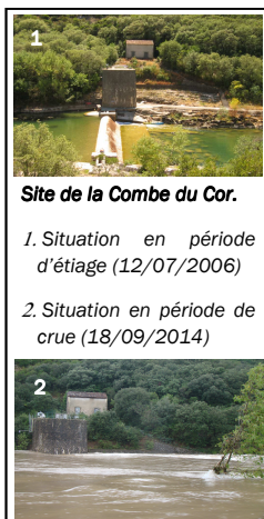
Site de la Combe du Cor. 1. Situation en période d'étiage (12/07/2006) 2. Situation en période de crue (18/09/2014)
